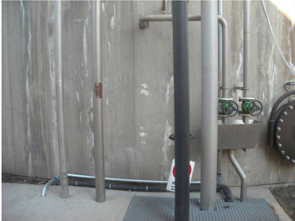
Tuberías de entrada de fangos, alivios, vaciados y tomamuestras.
