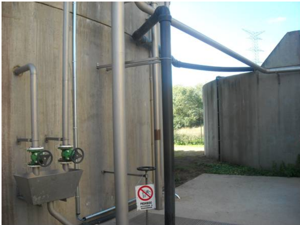
Tuberías de entrada de fangos, alivios, vaciados y tomamuestras.
