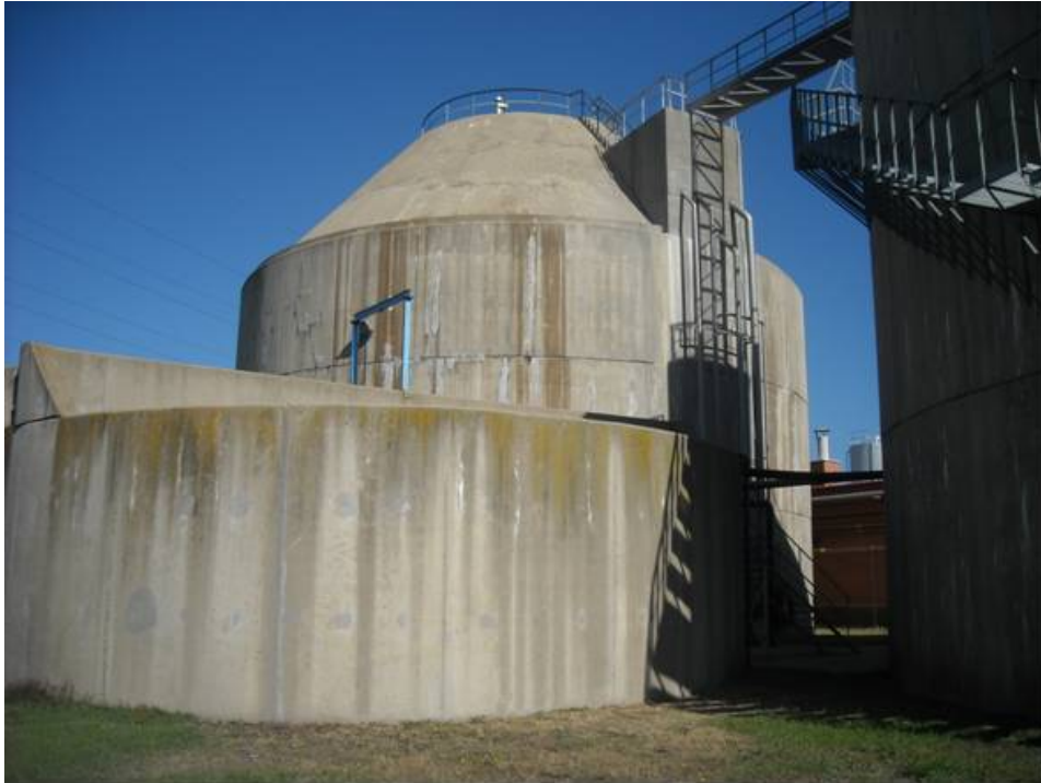
Digestores de fangos
