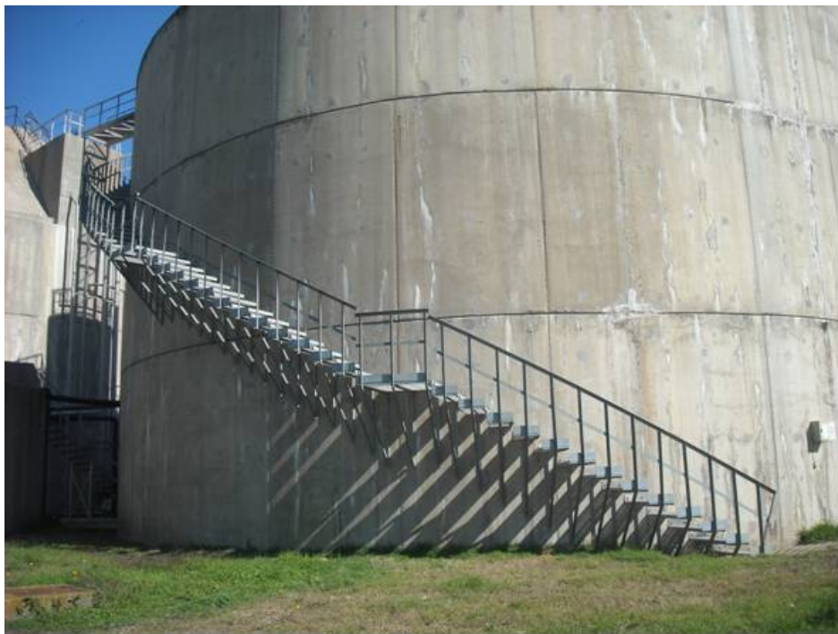
Escalera metálica de acceso a digestor
