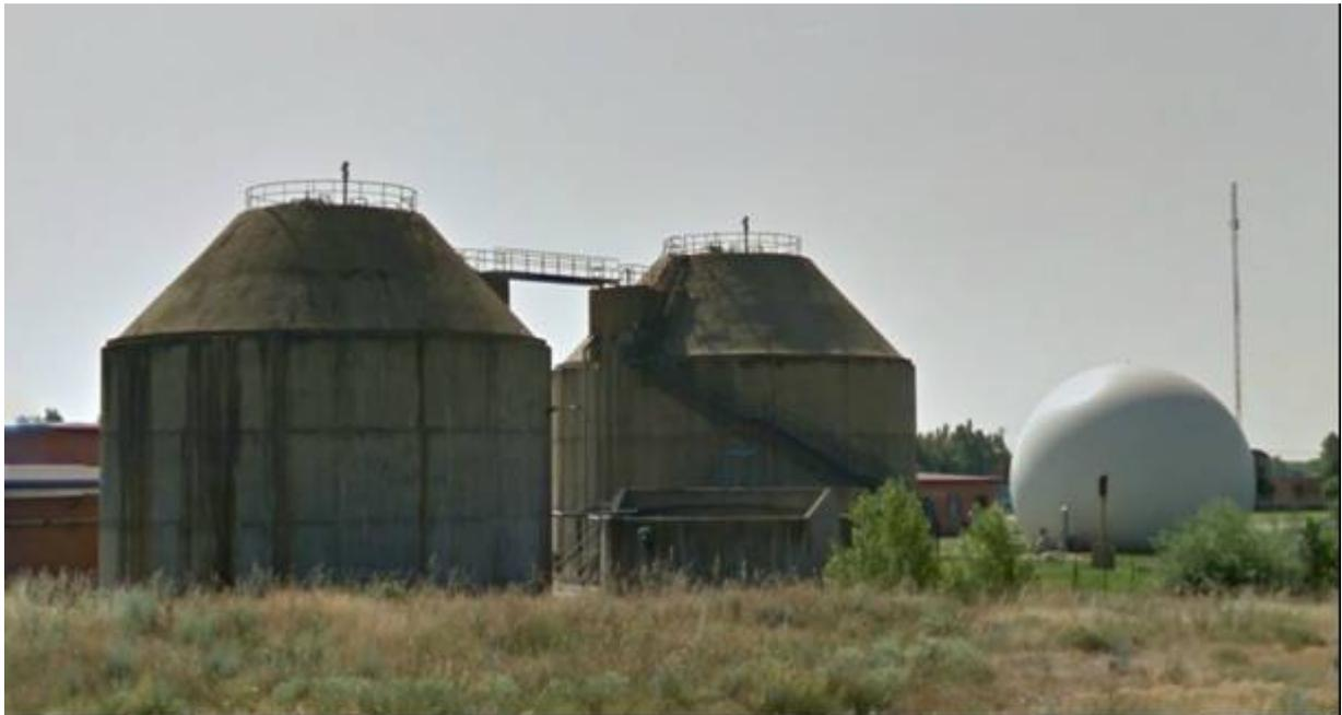
Estructuralmente están ejecutados en hormigón armado, con muros de 55 cm de espesor, solera de 55 cm y cúpula de 20 cm de espesor.
